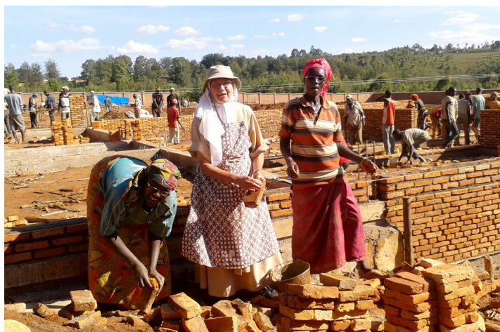
Les soeurs, sur le chantier de l'école
